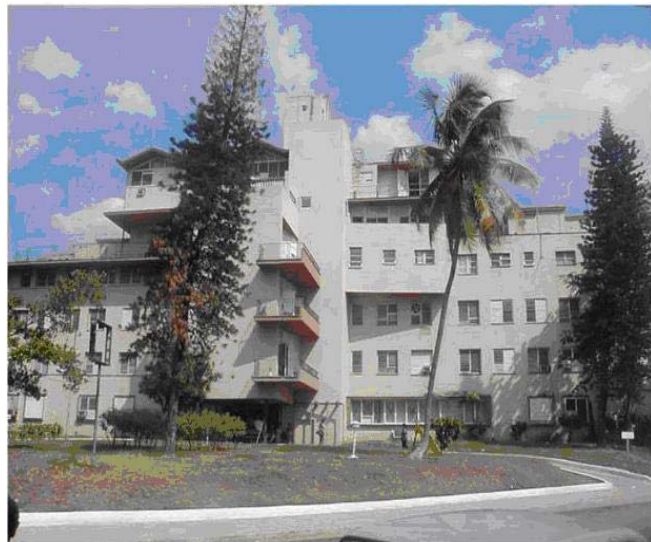
Figura 2. Instituto de Neurología y Neurocirugía. Vista de la fachada del edificio principal.
